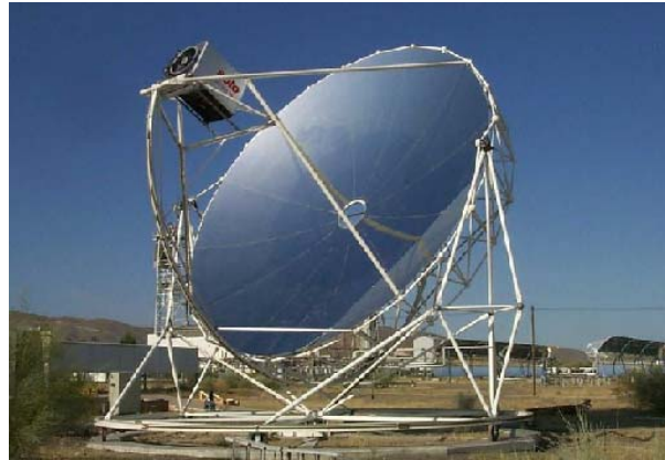
Ilustración 11. Concentradores de disco parabólico con motores Stirling
