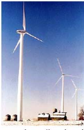
Rotor cuyo eje es paralelo a la dirección del viento (Horizontal)
