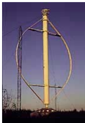
Figura 2.- Aerogenerador de eje vertical
