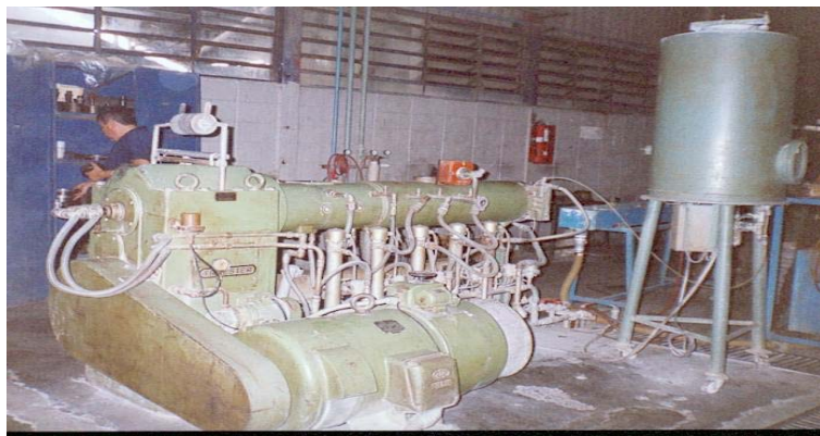
Figura 73: motor y transmisión de la extrusora
