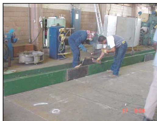
Figura A.44 Soldado de plancha para juntas tubulares (1) y plancha de refuerzo en unión de viga H (2)... [2].
