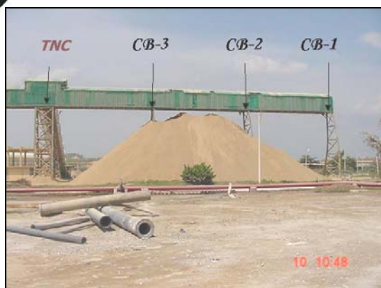
Figura A.1 Estructura 40-ET-03, lado oeste.
