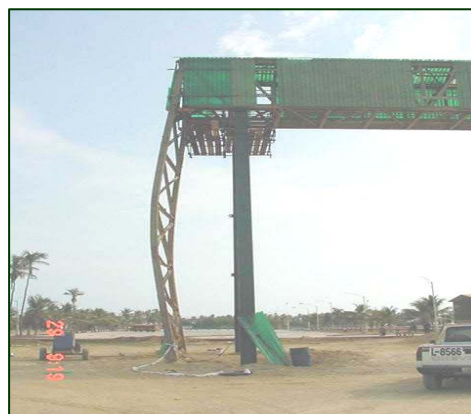
Figura A.64 Vista de norte al sur de nueva CB-1, visualizando pandeo de antigua CB-1 [2].
