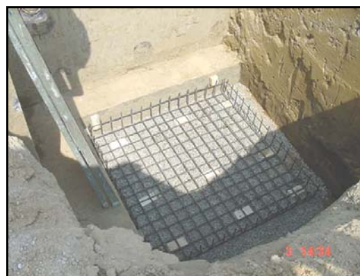
Figura A.36 Zapata de fundaciones (Estructura armada).
