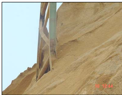
Figura A.32 Pandeo local producto de peso de RF.
