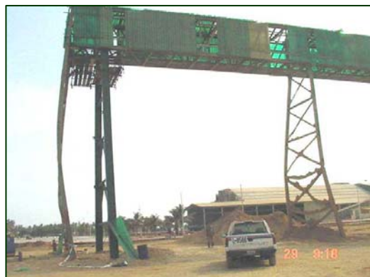
Figura A.63 Vista de norte al sur de nueva CB-1, visualizando pandeo de antigua CB-1 [1].
