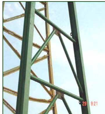
Figura A.68 Vista lateral de cerchas [2].
