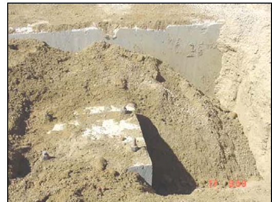
Figura A.61 Nueva fundación norte [2].
