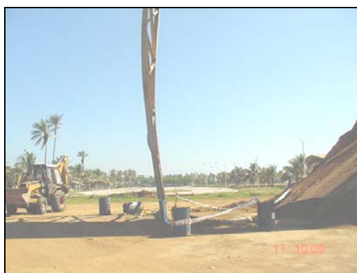
Figura A.54 Protección de seguridad de nuevas fundaciones.
