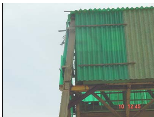
Figura A.12 Consecuencia del pandeo en plataforma Niv-14.
