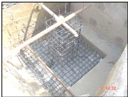
Figura A.37 Construcción de pedestal (Estructura armada) [1].
