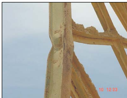
Figura A.15 Pandeo local, producto de choque de Maq. Pesada.
