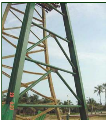
Figura A.67 Vista lateral de cerchas [1].
