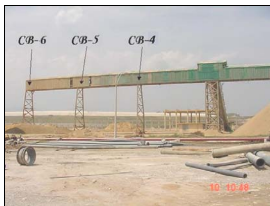
Figura A.2 Estructura 40-ET-03, lado este.
