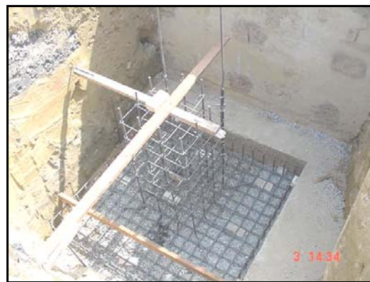
Figura A.38 Construcción de pedestal (Estructura armada) [2].
