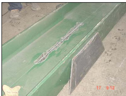
Figura A.49 Esmerilado para posterior soldado de plancha.
