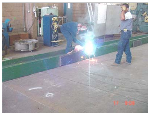
Figura A.45 Soldado de plancha para juntas tubulares (1) y plancha de refuerzo en unión de viga H (2)... [3].
