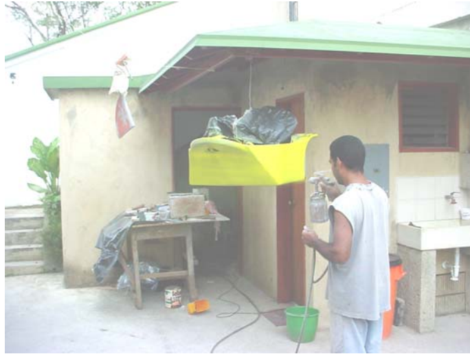
Figura 75: aplicación de la pintura
