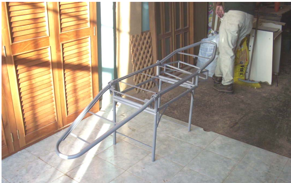
Figura 9.5. Acabado del ensamble luego aplicar el fondo anticorrosivo.
