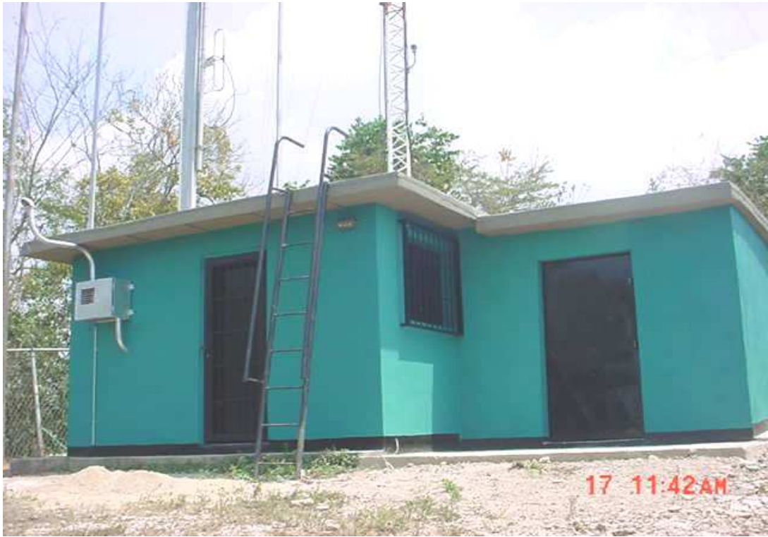
Imagen 3.3 Caseta repetidora sistema Losada Ocumarito
