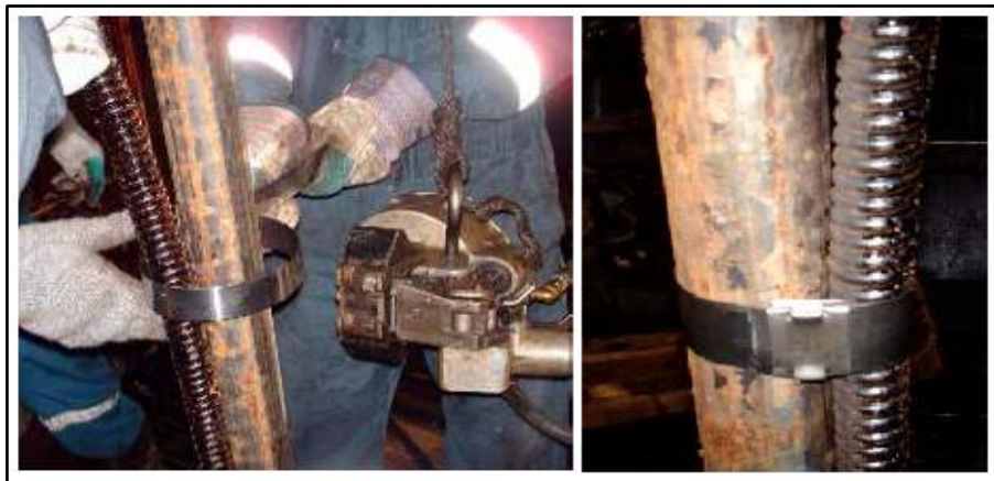
Figura 2. 12: Súper Bandas para la fijación del cable en la tubería.
