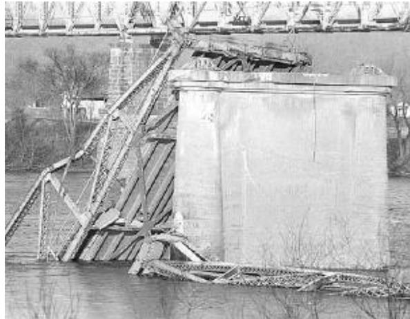
Figura 1.5 Puente de Point Pleasant colapsado.
