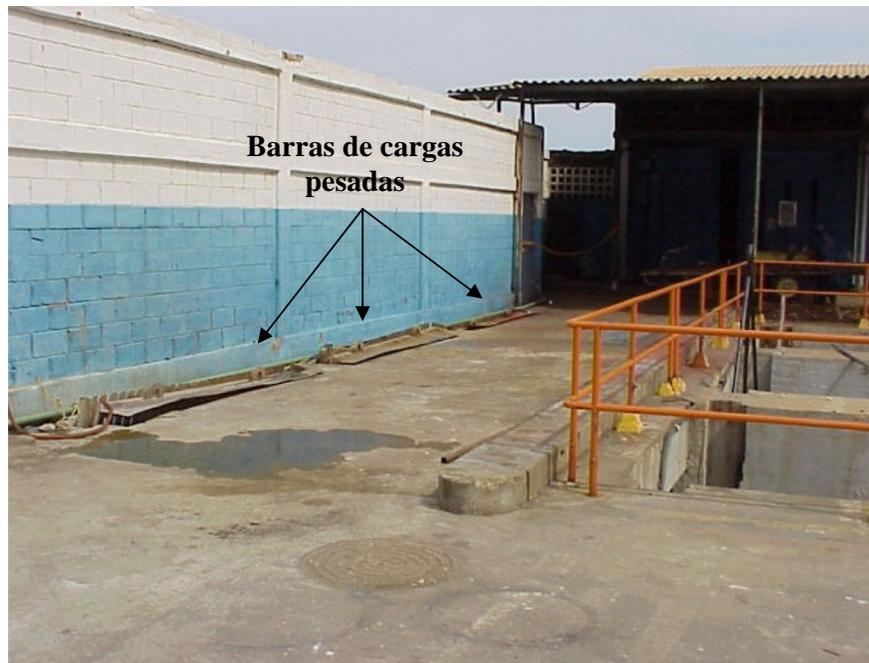
Figura 21. Barras de protección para cargas pesadas (Fuente: Autor)
