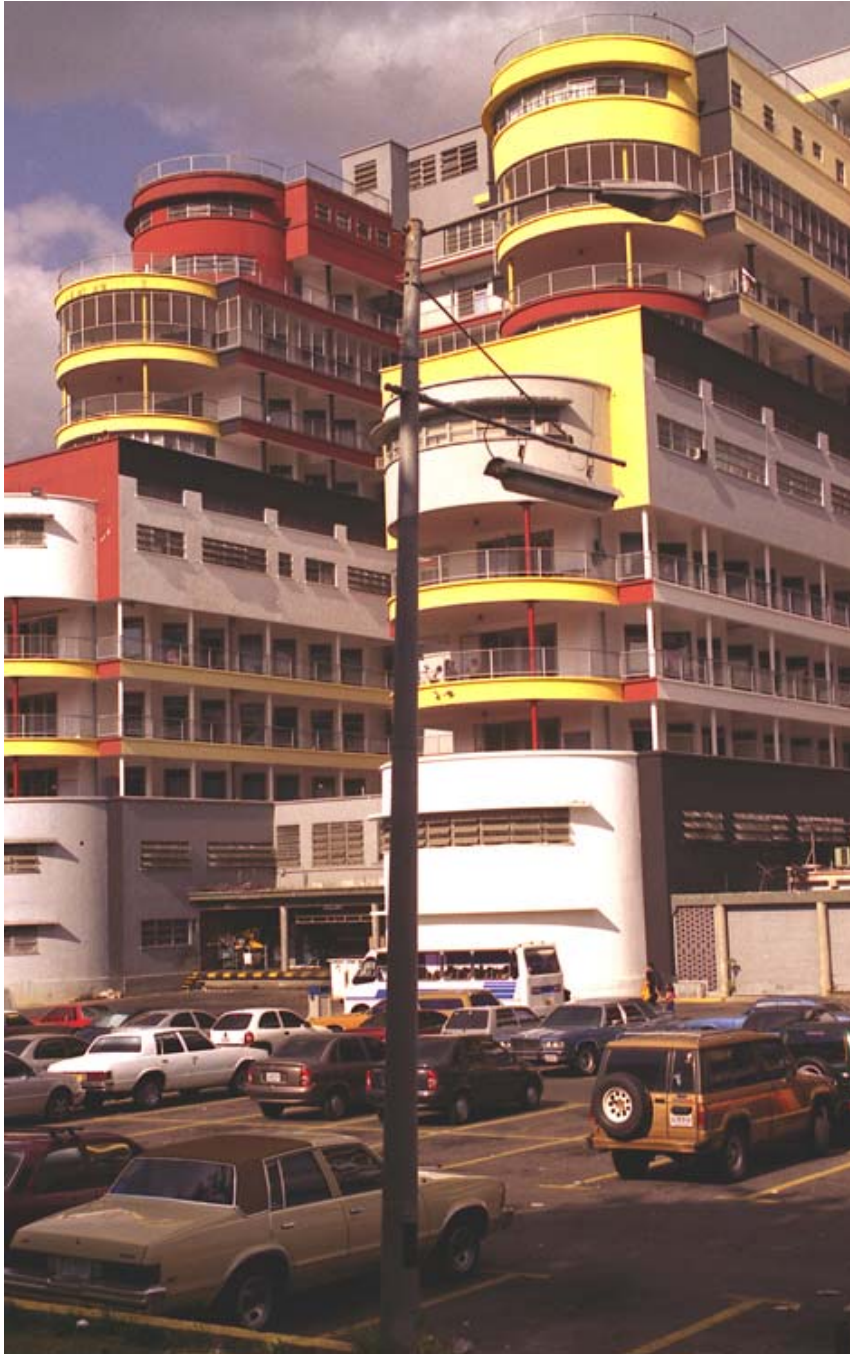
Esta Luminaria es del tipo modificada simple y está ubicada en el Estacionamiento del Hospital Clínico para médicos y empleados.
