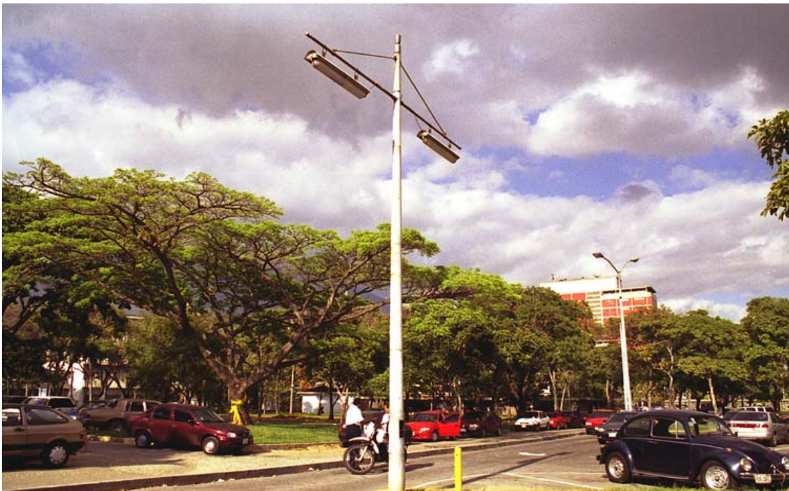
Esta Luminaria es original doble y muestra la ausencia de la Boca de Visita en el Poste.
