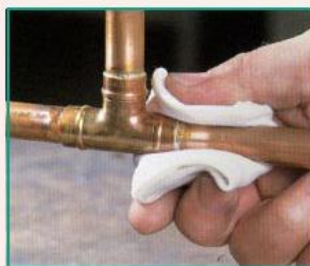
FIGURA 3.32. limpieza de la soldadura
