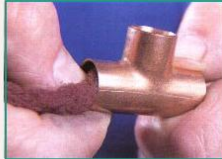
FIGURA 3.27. limpieza interior del accesorio
