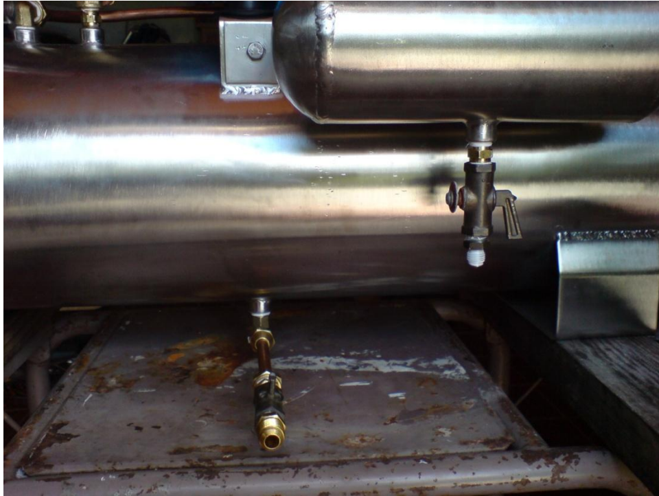
Figura N°4.15 Instalación de válvulas para realizar pruebas (Fuente: Referencia N°1)
