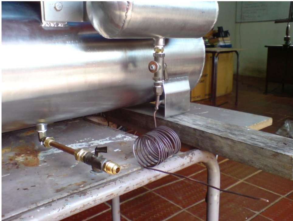
Figura N°4.17 Instalación de tubo de 2.0 mm completo (Fuente: Referencia N°1)
