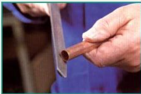
FIGURA 3.26. eliminación de rebabas
