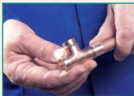
FIGURA 3.30. unión del tubo y el accesorio
