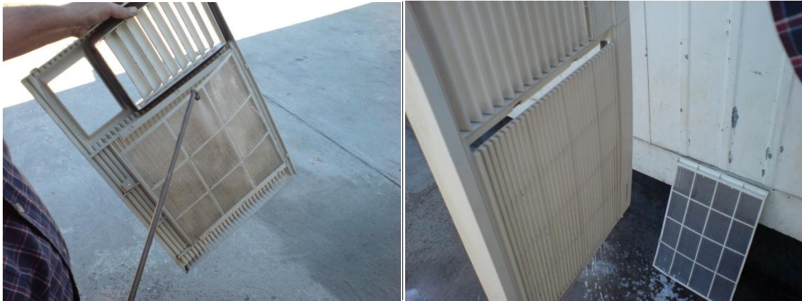
Figura N°4.28 Limpieza del frontal.
