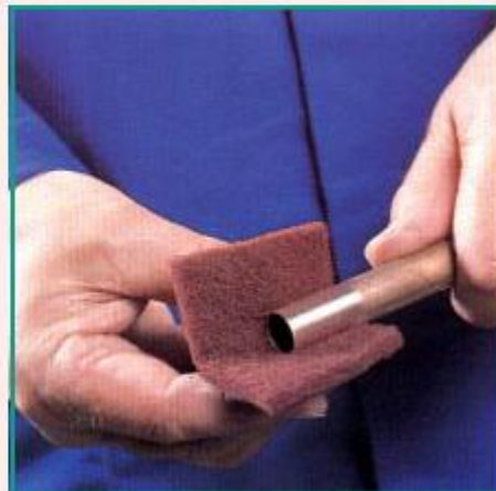
FIGURA 3.28. limpieza del extremo del tubo
