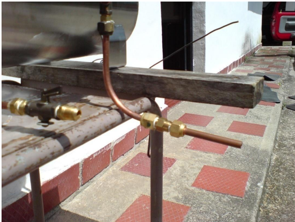
Figura N°4.16 Dispositivo para insertar la placa orificio instalado (Fuente: Referencia N°1)
