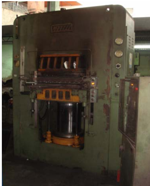
Figura 5.9 Área de Prensado en Caliente
