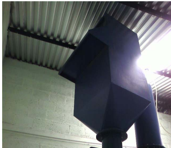
Figura 6.8 Vista 2 Mezcladora Nueva
