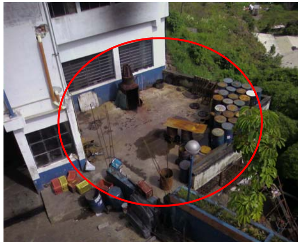
Figura 5.23 Vista 1 Nueva área de Vulcanización de Bandas
