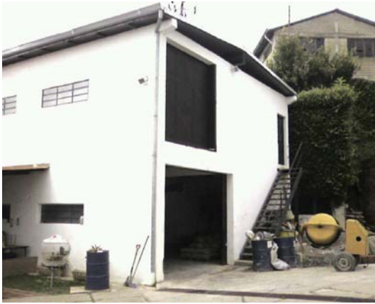
Figura 5.17 Vista 1 Galpón D
