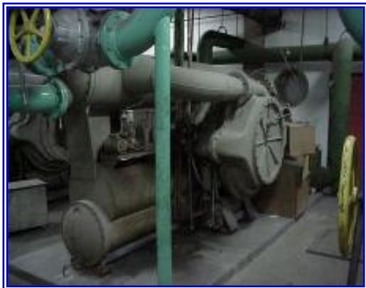
Figura II.1. Chiller enfriado por agua
