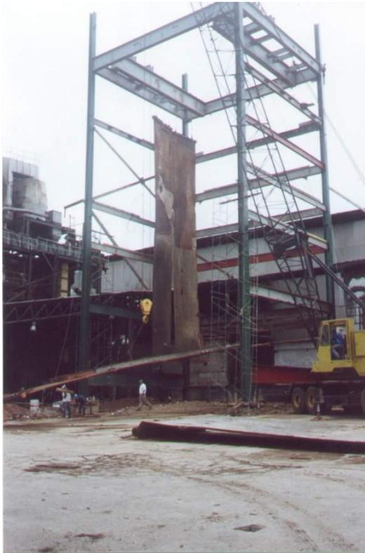
En estas imágenes se puede observar parte del proceso de montaje de los elementos del generador Babcock & Wilcox nº6 en el Central El Palmar S.A.
