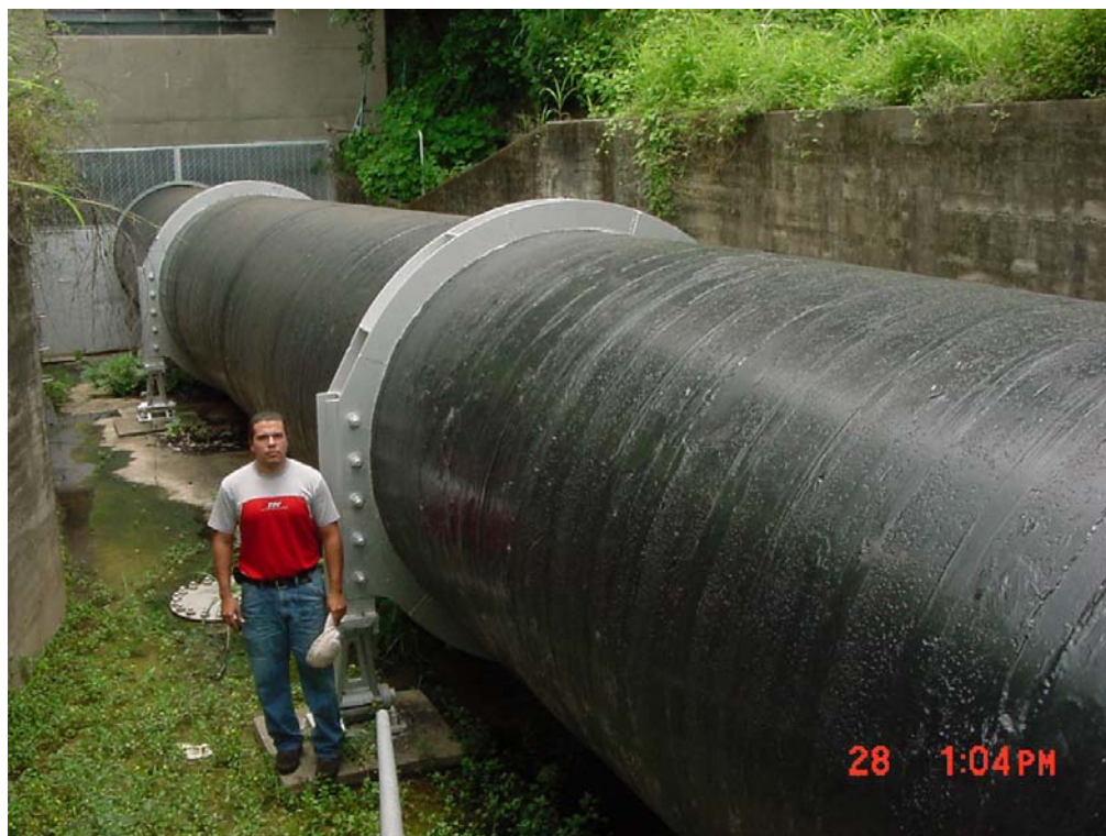
Foto 2 Tubería de Camatagua (D: 85 pulg)
