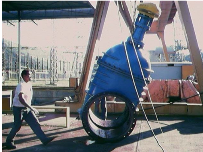
Ilustración 19 Válvula de Compuerta de la Estación 33
