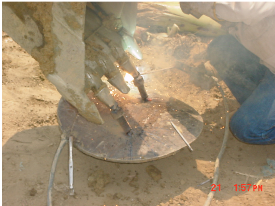
Foto 4 Reparación de fuga en Piloncito (Soldando lámina a Retroexcavadora)
