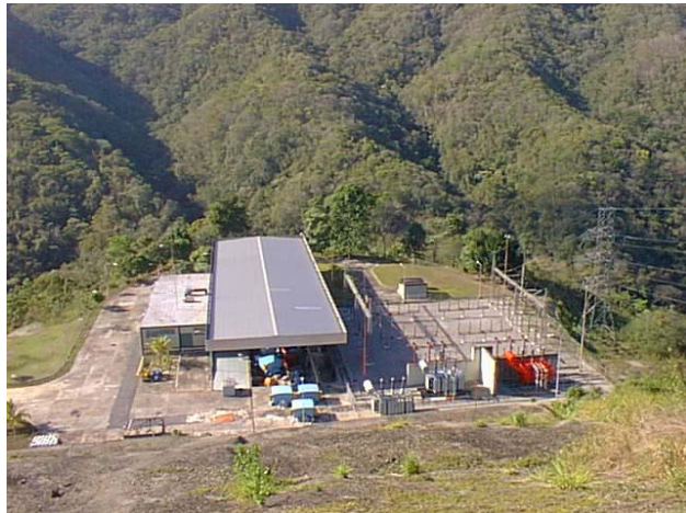
Ilustración 7 Vista general de la E/B 33
