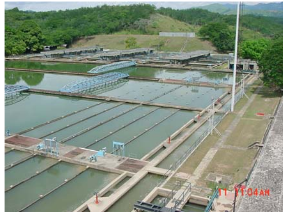
Ilustración 9 Planta de Tratamiento Caujarito
