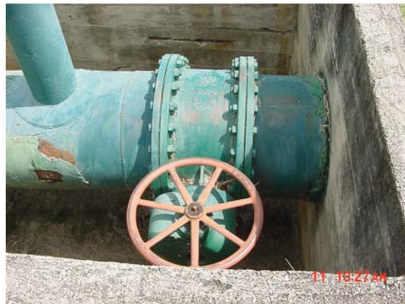
Ilustración 18 Válvula Mariposa ST
