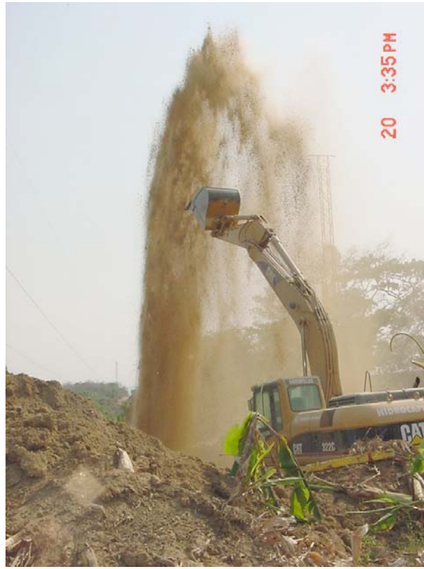
Foto 6 Cuadrilla reparando fuga
