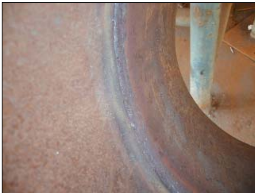
Figura 3.3.- INSPECCIÓN VISUAL DE LA ZONA INTERNA.
