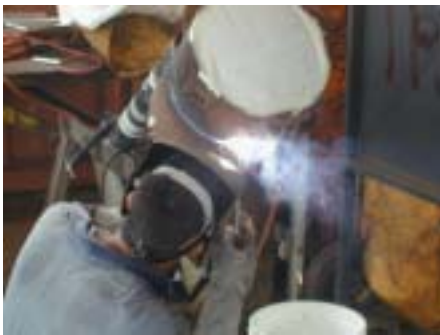
Figura 1.10.- PROCESO DE SOLDADURA SMAW
