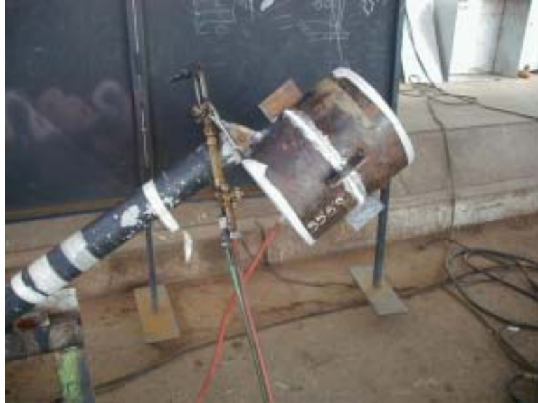
Figura 2.8.- ARMADO DE LA PIEZA.
