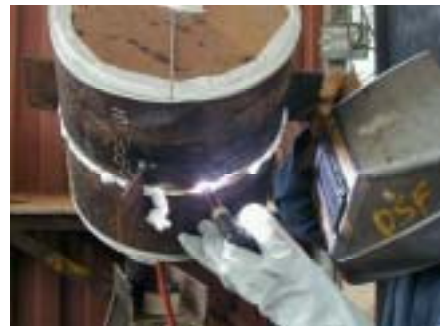
Figura 1.11.- PROCESO DE SOLDADURA GTAW
