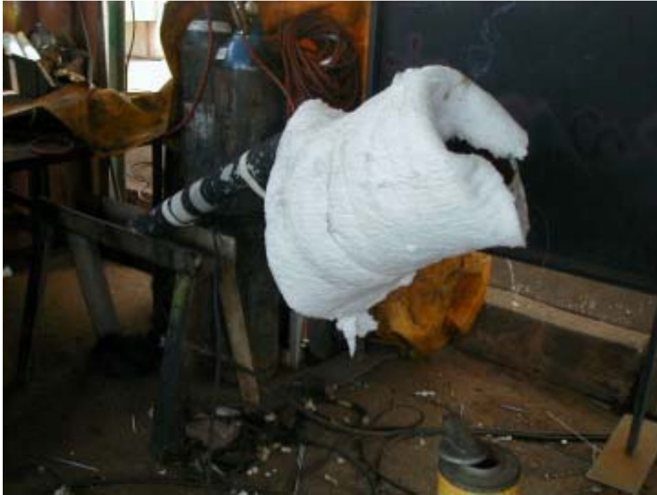
Figura 2.13.- ETAPA DE ENFRIAMIENTO DEL TRATAMIENTO TÉRMICO DE ALIVIO DE TENSIONES.
