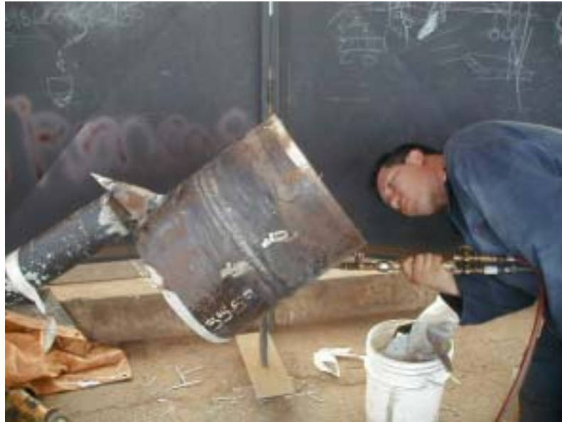
Figura 2.18.- INSPECCIÓN VISUAL ENTRE PASES MIENTRAS SE MANTIENE ADECUADAMENTE LA TEMPERATURA DE LA UNIÓN
