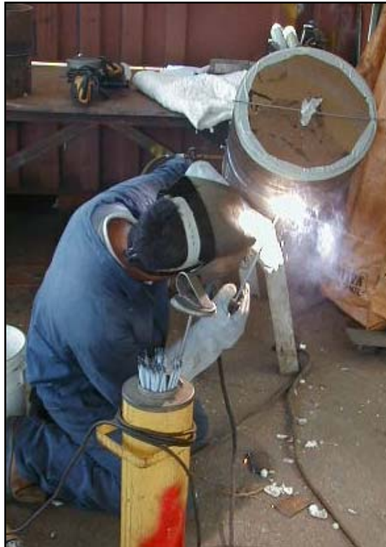
Figura 2.12.- PROCESO DE SOLDADURA SMAW
