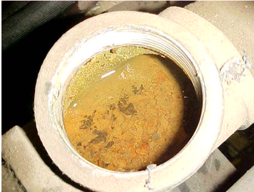
Figura 4.7 Incrustaciones en la red de alimentación. ( f_N = 3'' )
