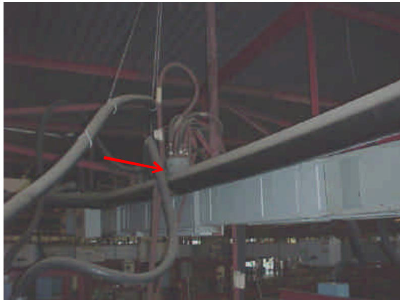
Fig. 4.15 Múltiple de la red de retorno cerrados al ambiente. ( f_N = 6'' )
