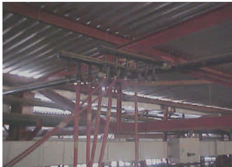
Fig. 4.16 Múltiplos de retorno de un sistema a presión. ( f_N = 2'' )
