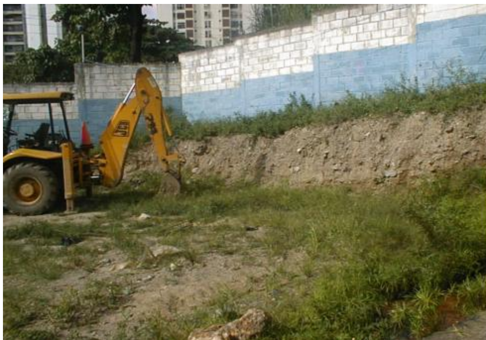
Ilustración 5.1 Terreno destinado para la nueva estación de bombeo
