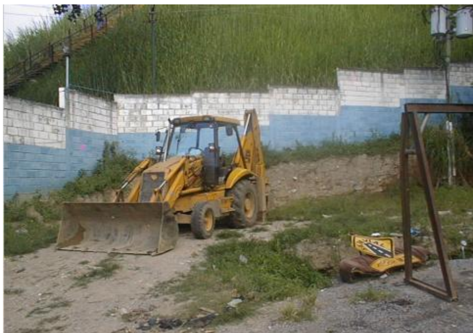
Ilustración 5.2 Terreno destinado para la nueva estación de bombeo
