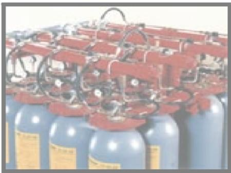
INERGEN es una mezcla de Nitrógeno, Argón y CO<sub>2</sub>, estos son gases naturales presentes normalmente en el aire que respiramos. Su nombre se deriva de inerte y nitrógeno. La mezcla utilizada es la siguiente: 52% Nitrógeno,
