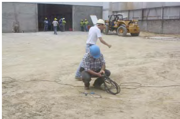
Fig. 3 Adquisición sísmica en una zona industrial en construcción. Tanto la maquinaria como el personal ubicados al fondo de la fotografía debieron detener sus labores para permitir al equipo de campo realizar su trabajo. Los problemas logísticos y de costos en este tipo de situaciones resultan en inconvenientes que deben ser superados. (Foto del Archivo del Departamento de Geofísica-UCV).
