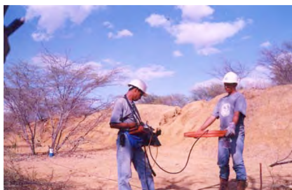
Fig. 4 Adquisición electromagnética en la base del muro de contención de una fosa petrolera. En este caso el objetivo no requería abarcar una gran área sino realizar mediciones muy cercanas unas de otras para incrementar el nivel de
