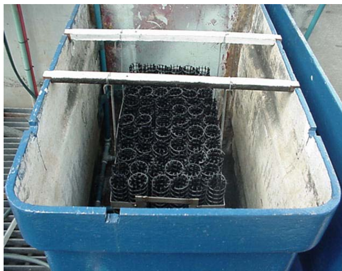
Figura 15: Ubicación del medio dentro del tanque
