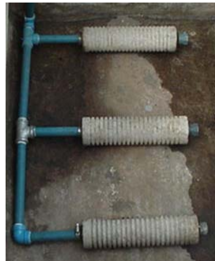
FIGURA 19: Fotografía de los sistemas de difusión de aire correspondiente al sistema de lodo activados.
