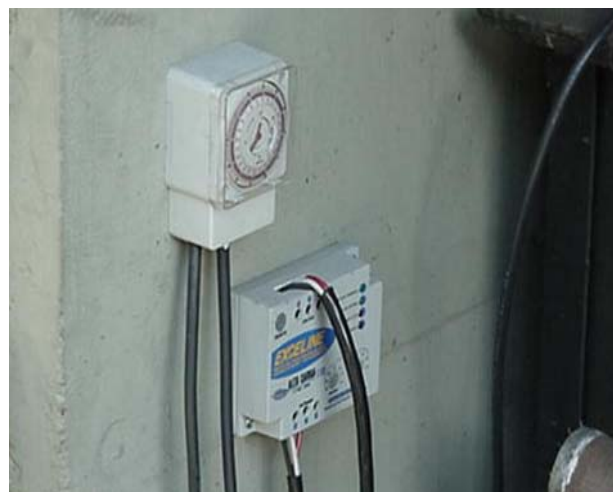
FIGURA 13: Protector de seguridad de los compresores (derecha) y timer (izquierda).
