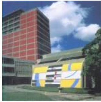
Figura 71: Vista exterior del conjunto central UCV. C. R. Villanueva.(1950-1958) Ccs. Vzla.
