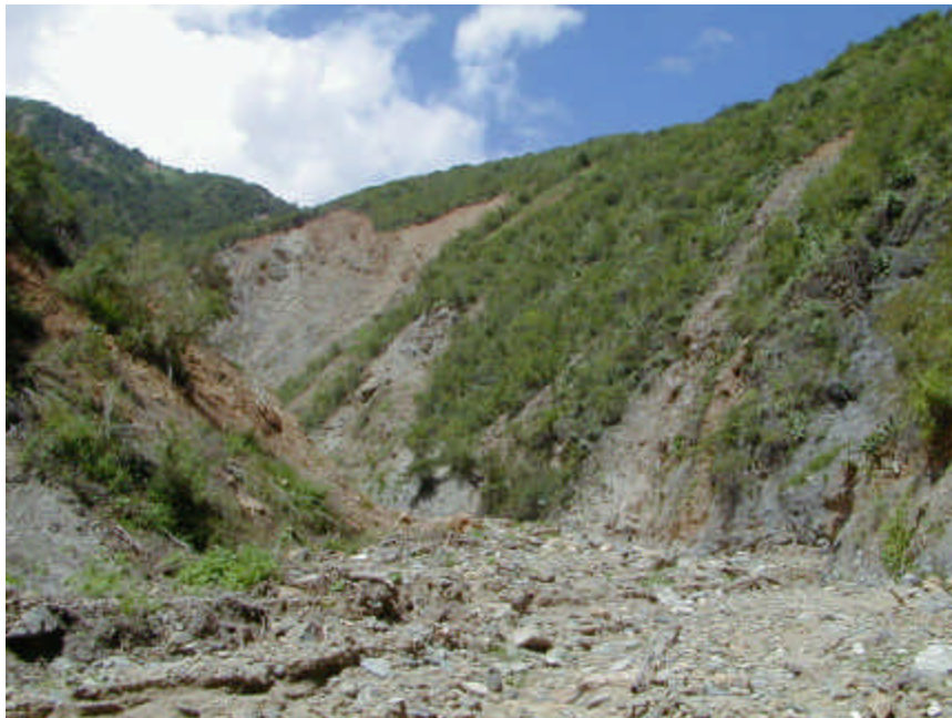
Figura 19. Ejemplo de como los deslizamientos laterales en las laderas cercanas al drenaje incorporan nuevo material en los flujos torrenciales. Quebrada Alcantarilla ubicada al Oeste del poblado de Macuto. WIECZOREK (2000). (Rumbo aproximado de la foto N-S).
