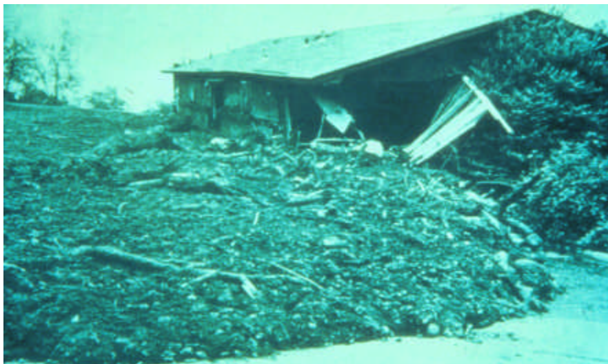
Figura 24. Frente destructivo de flujos de lodo, nótese la poca velocidad del mismo. Tomado de JULIEN (2000).
