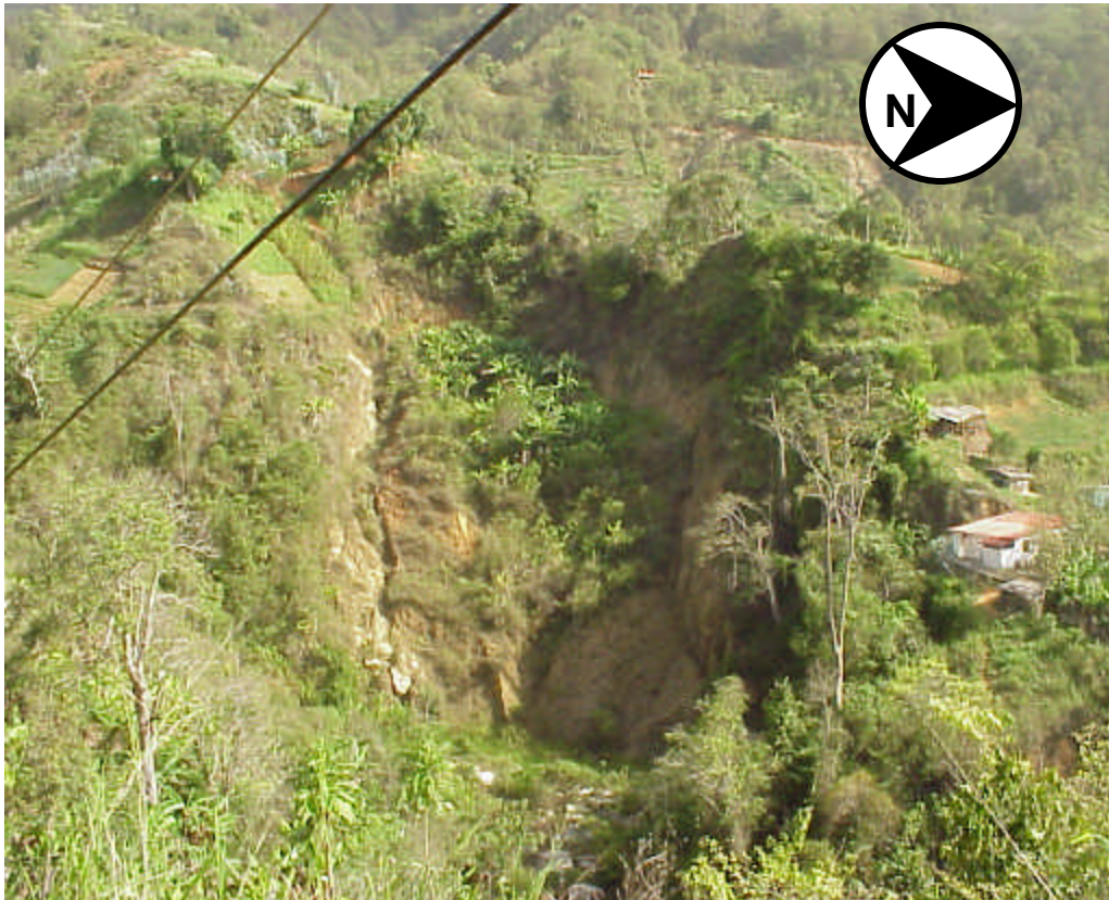
Figura 52. Deslizamiento rotacional de suelo en el punto SJdG 0 ubicado en la cuenca media, ladera Oeste del río San José de Galipán. Las cárcavas presentan una profundidad de aproximadamente 2,5 m y el suelo es limoso de color rojizo. (Rumbo de la S60°W).
