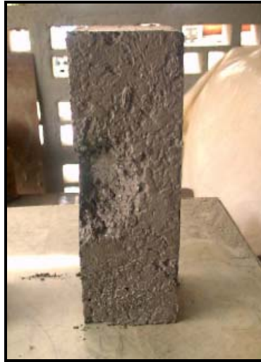
Foto II.15 Viga pequeña antes de la reparación
