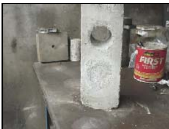
Foto II.15-E Reparación de orificio por extracción de núcleo con microconcreto-otra vista
