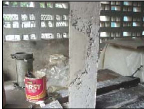
Foto II.15-B Reparación de viga con microconcreto
