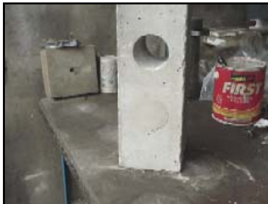
Foto II.15-D Reparación de orificio por extracción de núcleo con microconcreto
