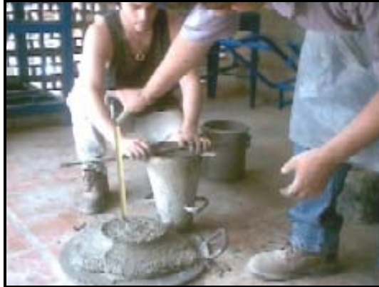
Foto II.10 Medición del asentamiento
