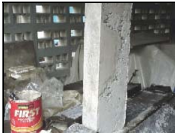
Foto II.15-C Reparación de viga con microconcreto
