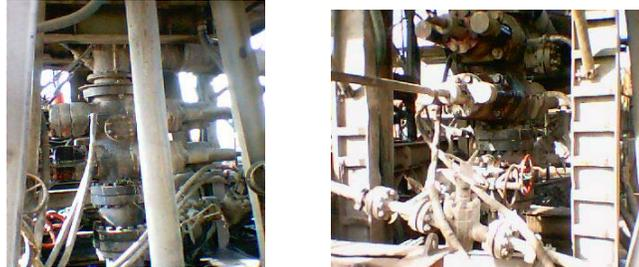
Figura. III 35 Válvulas Impide Reventones
