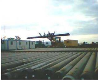
**Figura VI 5** Traslado de Revestidores
