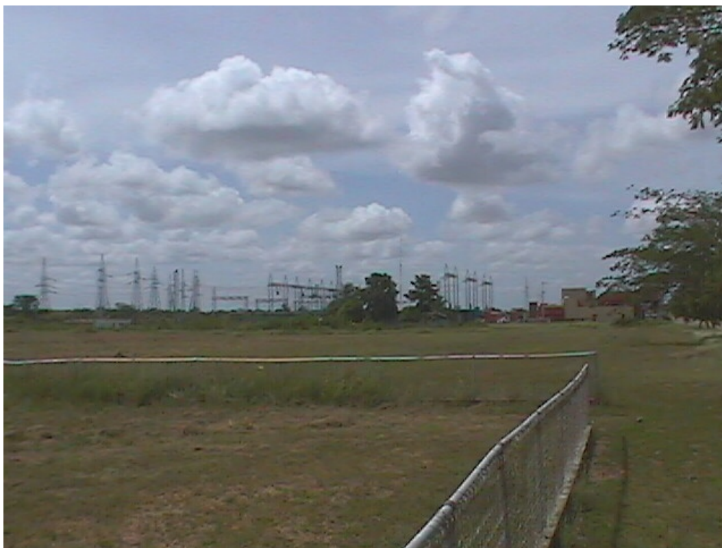
Figura 6.9, Vista Oeste del lugar sugerido para la instalación de la unidad (Planta Alfredo Salazar-Anaco)
