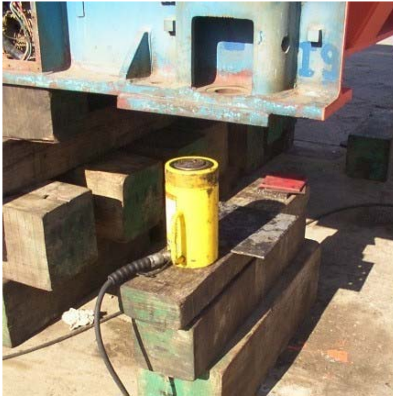
Figura 7.4, Gato hidráulico usado para levantar los compartimentos
