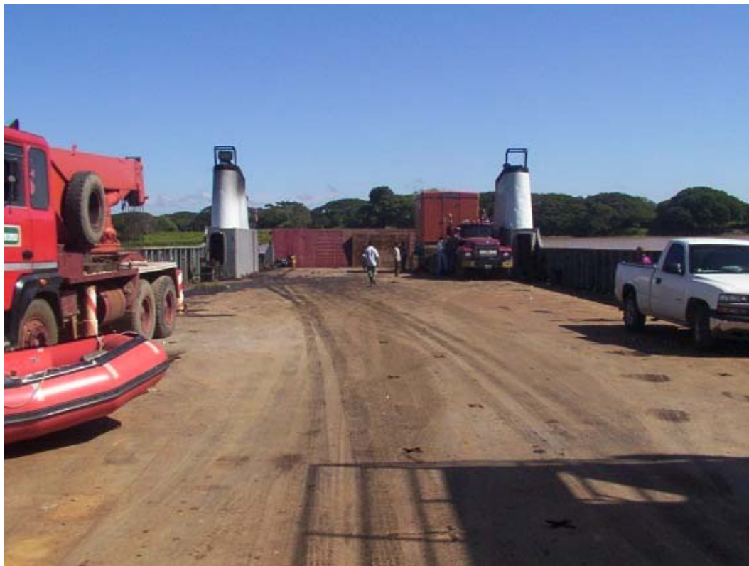
Figura 7.15, Vista interior posterior de la unidad de transporte marítimo
