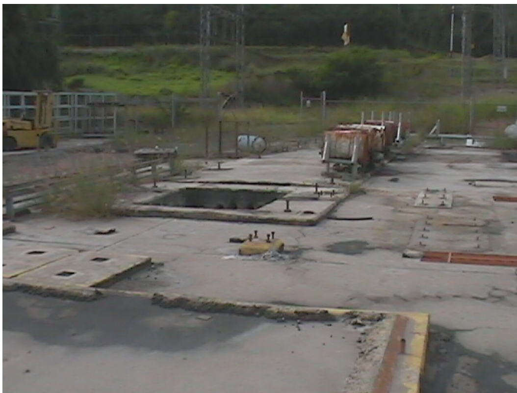
Figura 6.15, Antiguas bases de turbinas MS-5001 (Planta Guanta-Guanta)
