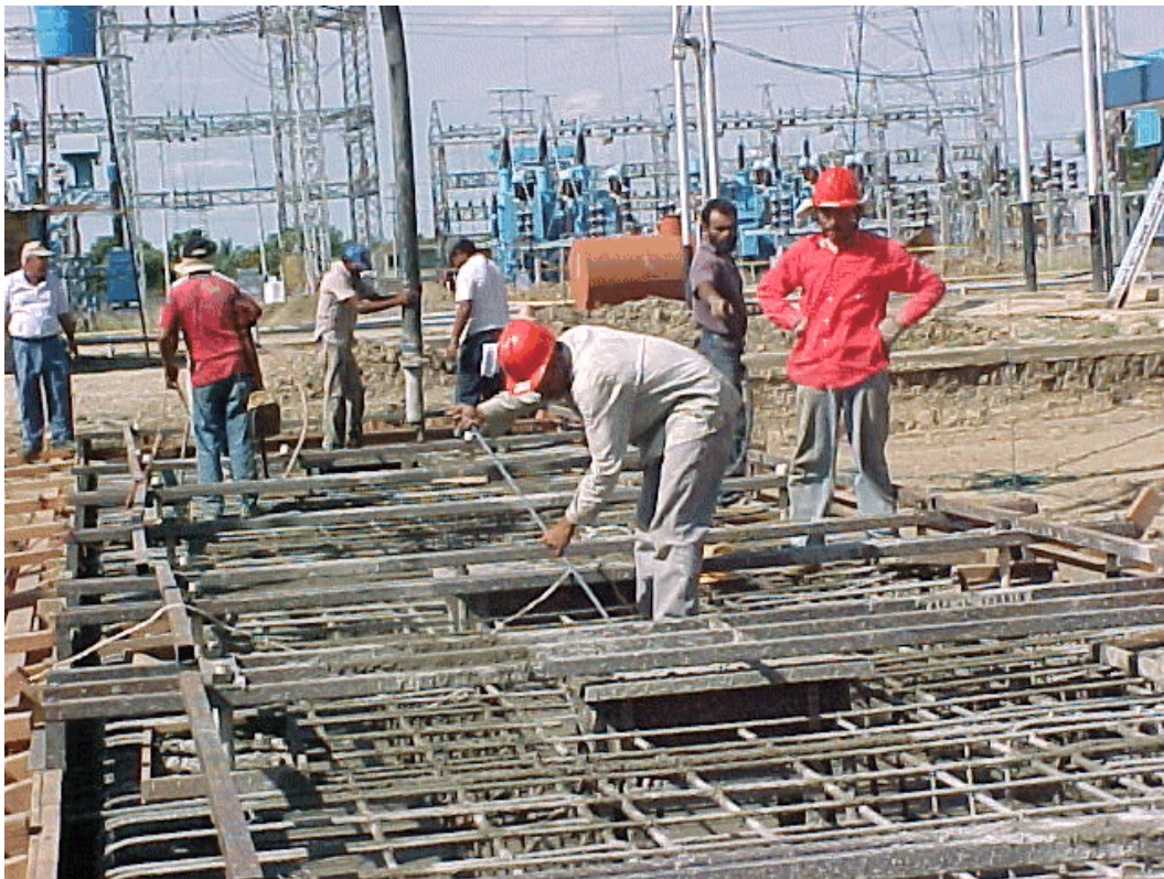
Figura 8.1, Enmallado de la base de la turbina
