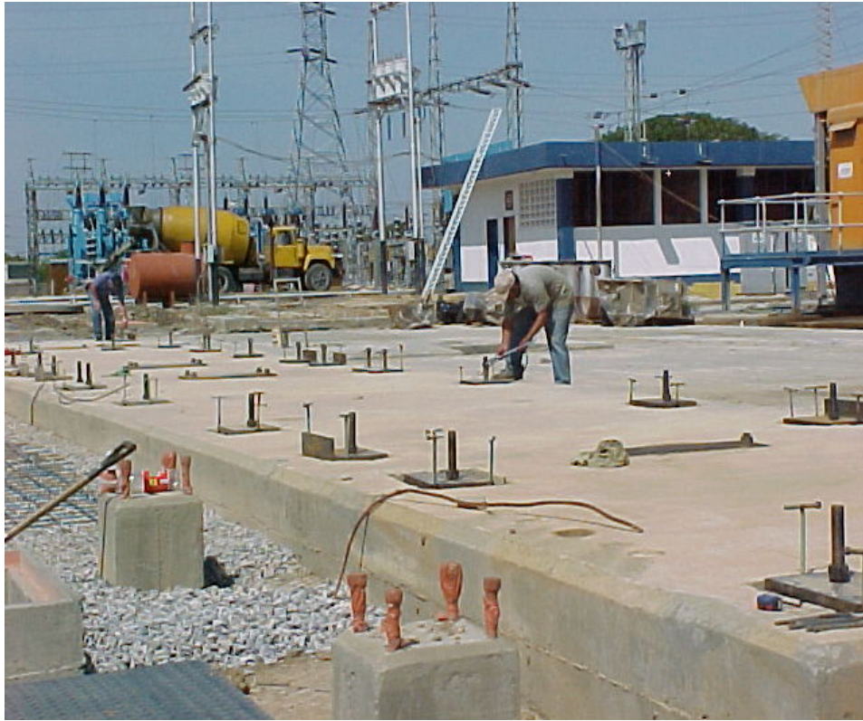
Figura 8.2, Base de la turbina, ya fraguada
