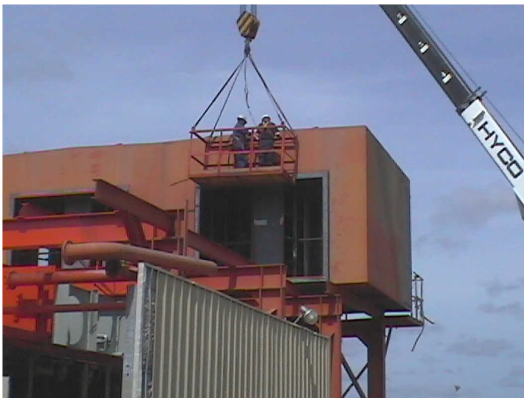
Figura 6.1, Mantenimiento mayor en la casa de filtros de una unidad MS-7001E (Planta Alfredo Salazar-Anaco)
