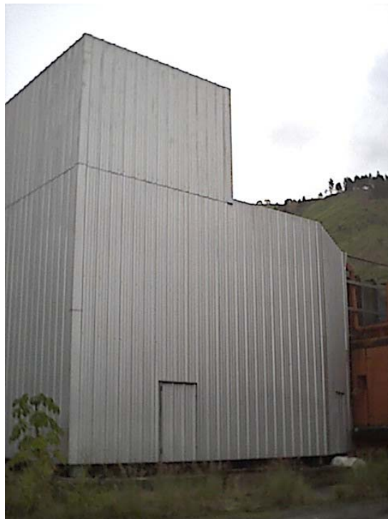
Figura 5.18, Aspecto exterior de la chimenea de la turbina
