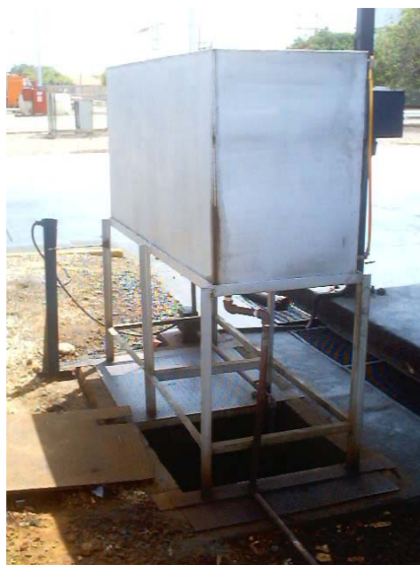
Ilustración 6.13 Tanque de recolección de fugas en el sistema de llenado
