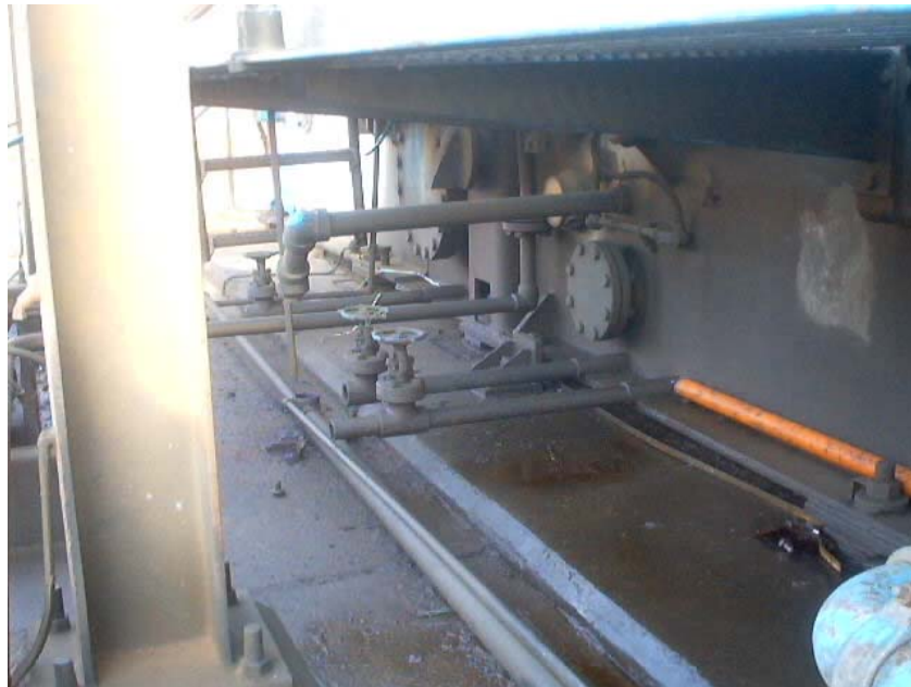
Ilustración 6.2 Drenaje de la unidad
