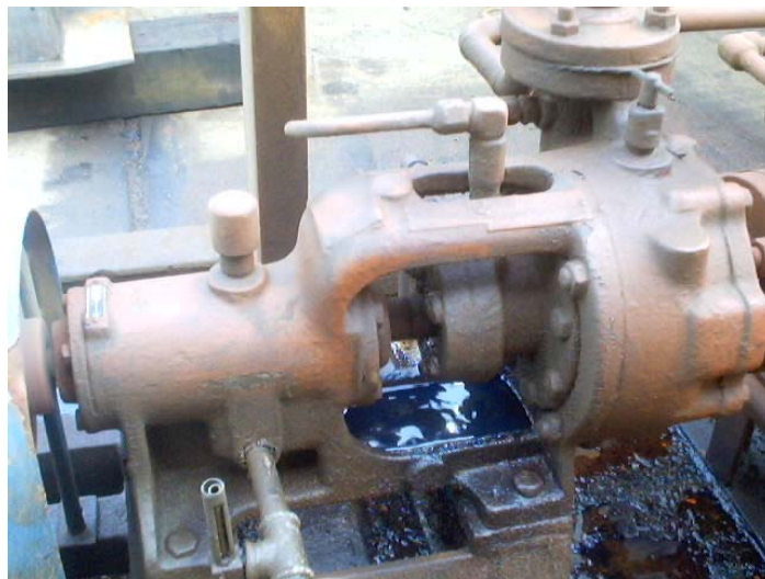
Ilustración 6.6 Fugas en el fuel forwarding skid
