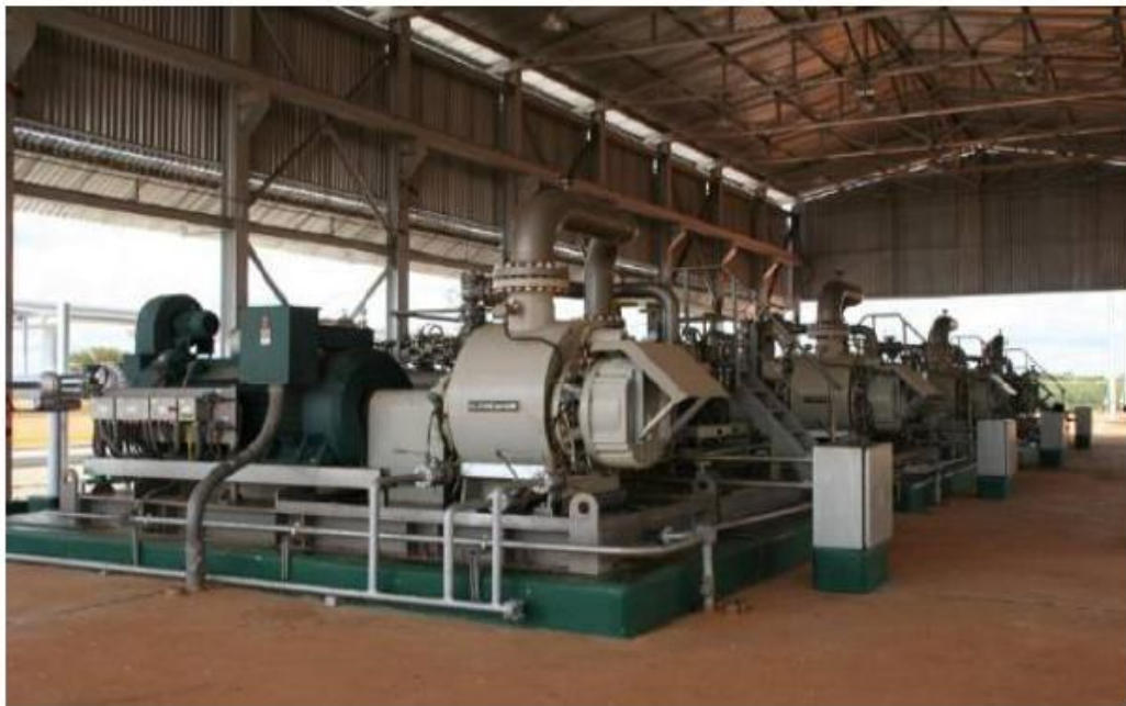
Figura 2.11. Bomba multifásica de doble tornillo [5].
