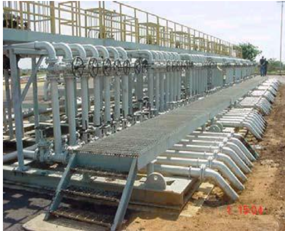
Figura 2.4 Múltiple de tuberías [3]
