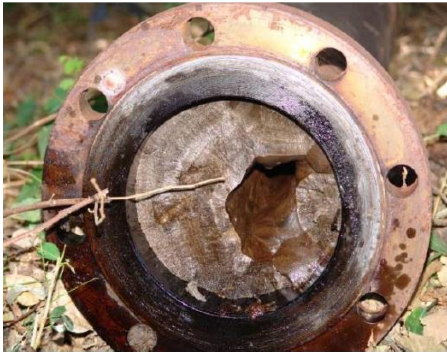
Figura 5.15 Pozo del Estado Barinas afectado por incrustaciones de \text{CaCO}_3 [14] .
