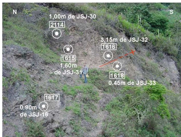
Figura 40: Secciones parciales JSJ-30, 31, 32, 33 y JSJ-16 (tomada en dirección 80°).
