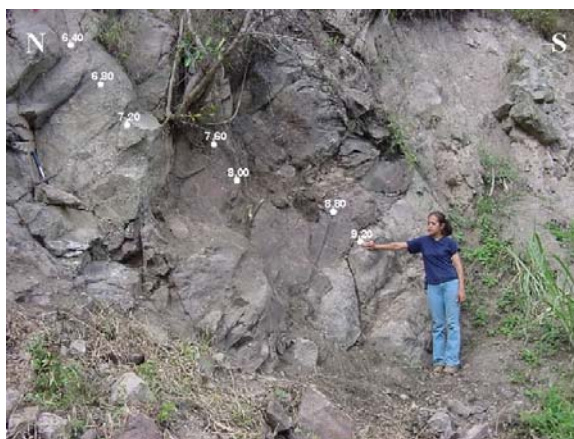
Figura 14: Profundidades de la sección parcial JSJ-26 (tomada en dirección 100°).
