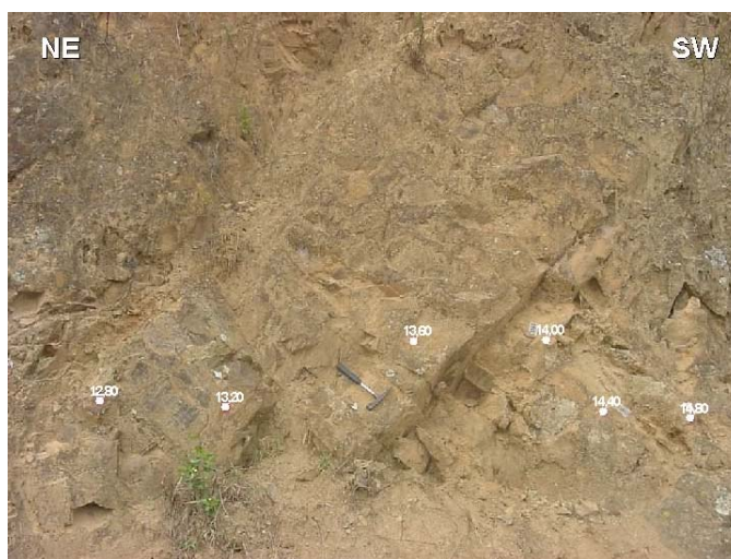
Figura 15: Profundidades de la sección parcial JSJ-3 (tomada en dirección 45°).
