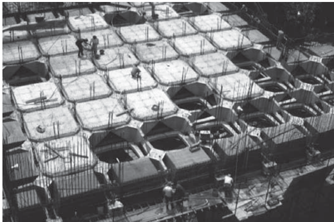
Figura 10. Construcción del Museo de Bellas Artes (1971). Fuente: Archivo personal de José A. Peña.
