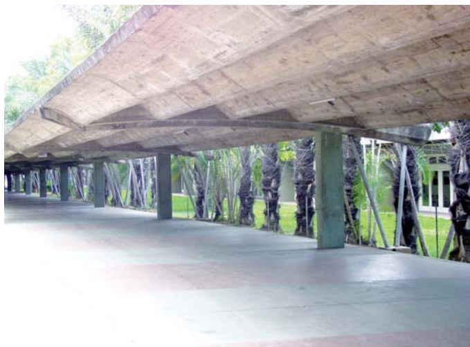
Figura 6. Pasillo Ingeniería-Humanidades CUC (1953). Fuente: Archivo personal de Iván González Viso.
