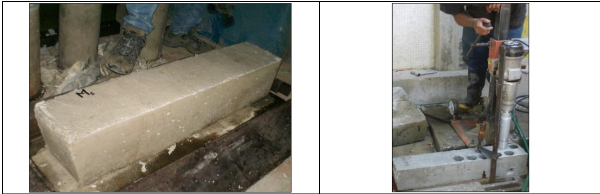
Figura 16 Desencofrado de viguetas y extracción de núcleos. (Elaboración propia)
