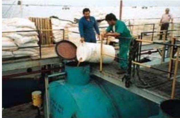
Figura 25-D.3: Trabajadores introduciendo la mezcla de bacterias e inhibidor de corrosión dentro del tanque [105]
