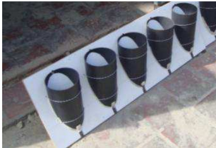
Figura III. 12. Formaletas cilíndricas con corte a treinta grados
