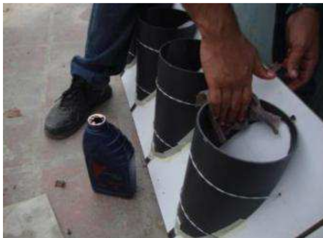
Figura III. 19. Engrasado de formaletas con corte de treinta grados
