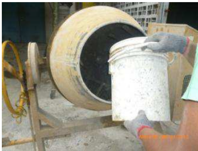
Figura III. 15. Elaboración de la mezcla, mezclado de los componentes
