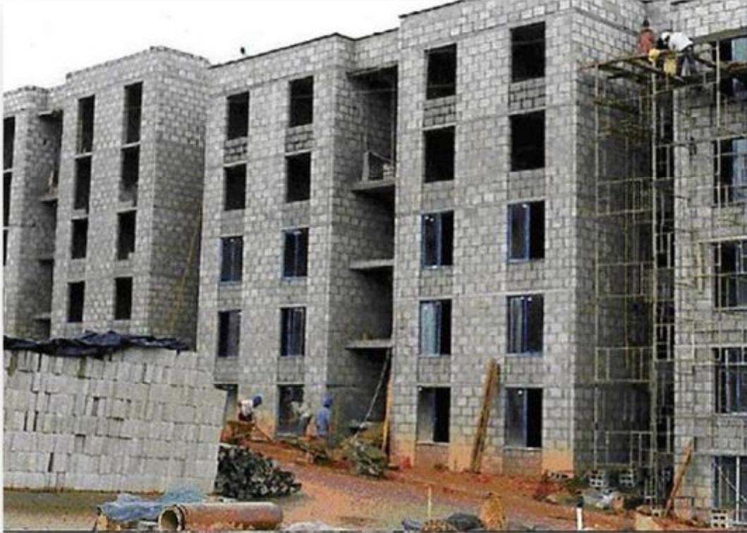
**Figura 2.3.** Estructuras de mampostería Armada. Fuente: <http://www.virtual.unal.edu.co>
