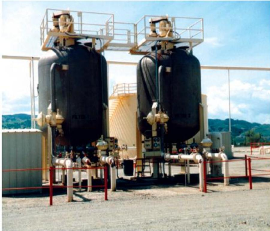
Figura VII.29. Filtros de cascara de nuez aplicados en una operación de inyección de vapor
