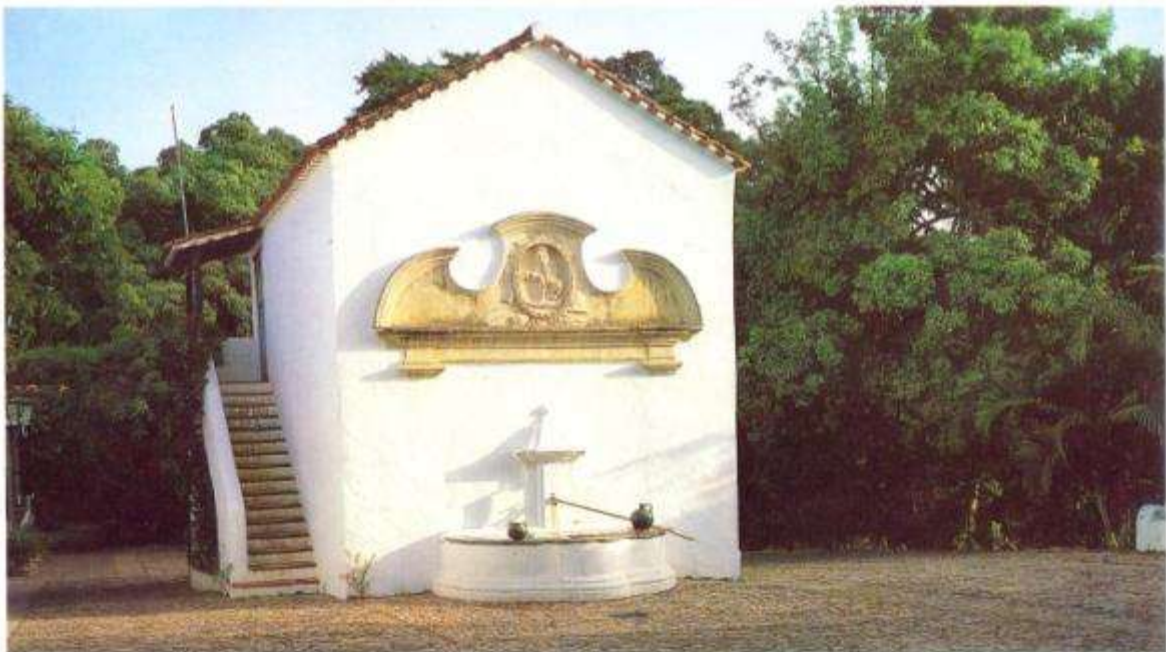
Figura N° 17. Pila de agua de la esquina de Muñoz
