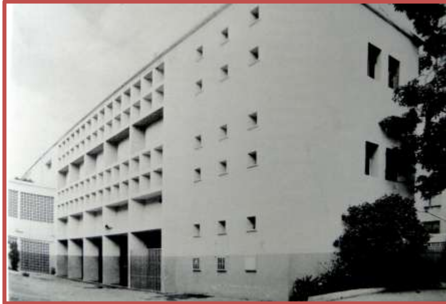
Figura No. 33. Vista de los corredores del Internado de la Escuela Normal Miguel Antonio Caro. Tomado de <<Hernández de Lasala, S., 1990, p. 211>>.
