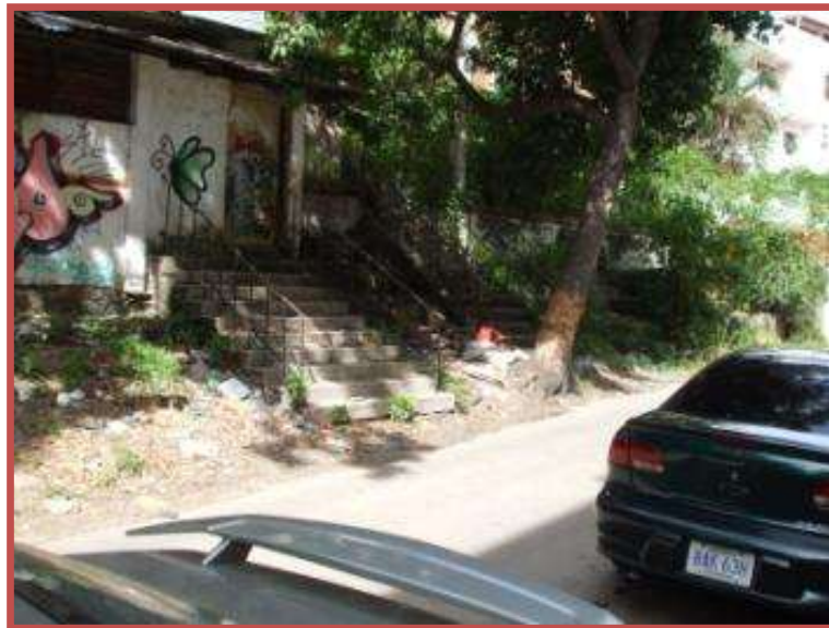
Figura No. 79. Edificación perteneciente a la antigua biblioteca de la urbanización, 2011. Grupo Escolar “Agustín Zamora Quintana”. Tomado de <<Fotos propias del autor>>.
