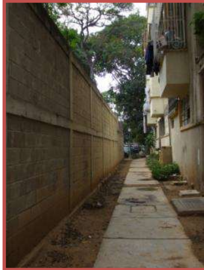
Figura No. 76. Pared perimetral Norte, paralela al bloque 4, 2011. Grupo Escolar “Agustín Zamora Quintana”. Tomado de <<Fotos propias del autor>>.
