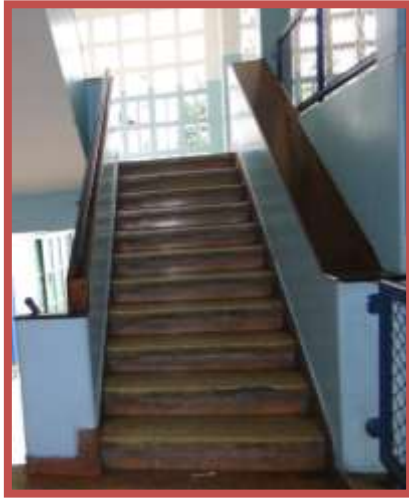
Figuras No. 51. Pasamanos de las escaleras en acabado de madera, 2010. Tomado de <<Fotos propias del autor>>.
