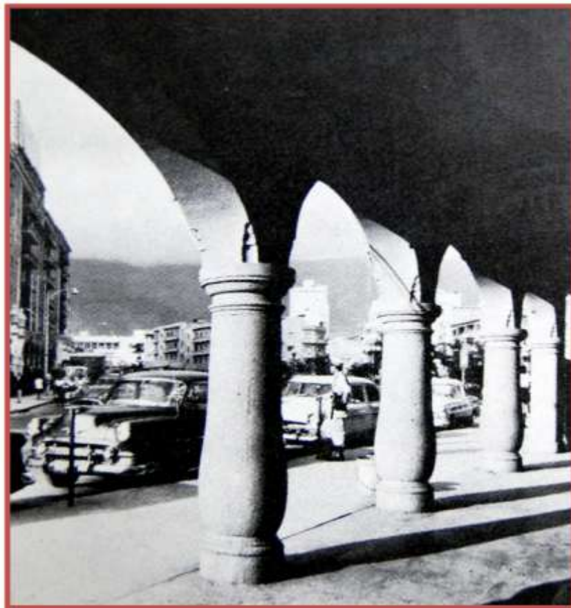
Figura No. 9. Imagen de las columnas panzudas neo-coloniales de los pasillos perimetrales de la Urbanización El Silencio. Imagen tomada de <<Caracas a Través de su Arquitectura>>. Gasparini, 1998, p. 303.
