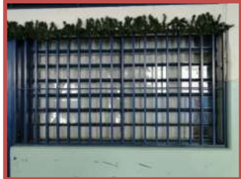
Figuras No. 54 y 55. Ventanas de hierro y de hierro y vidrio tipo romanilla con rejas de barras metálicas colocadas por seguridad, 2011. Tomado de <<Fotos propias del autor>>.
