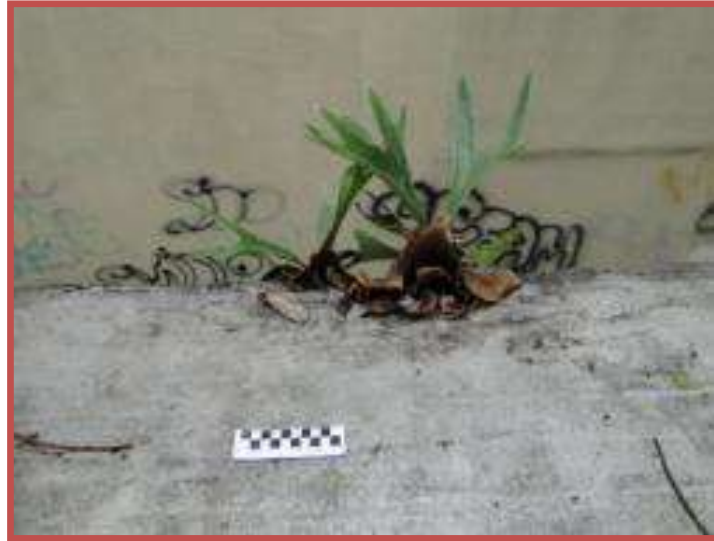
Figura No. 66. Presencia de vegetación en alero de la fachada Oeste (losa maciza de concreto), 2011. Grupo Escolar “Agustín Zamora Quintana”. Tomado de <<Fotos propias del autor>>.
