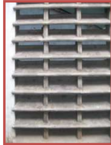
Figuras No. 43 y 44. Concreto presente en la estructura y en los bloques de ventilación del grupo escolar Agustín Zamora Quintana. 2011. Tomado de <<Fotos propias del autor>>.
