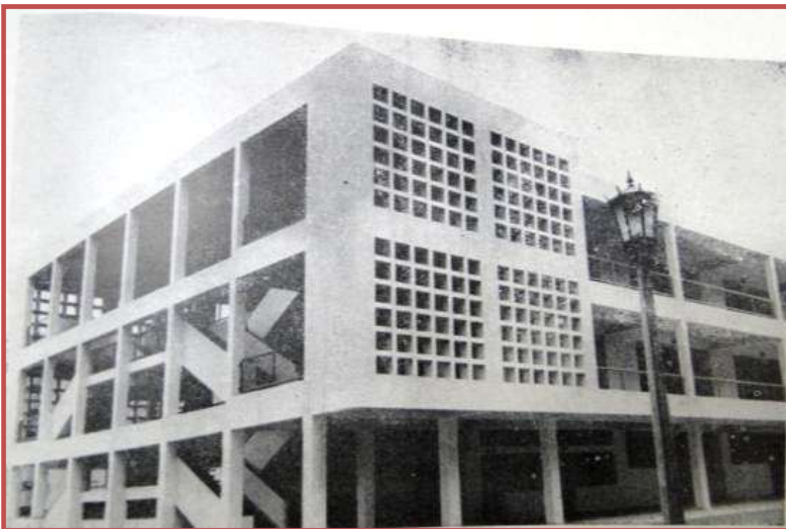
Figura No. 26. Vista de las fachadas Norte y Este. Se observa el módulo de circulación vertical. Tomado de <<Memorias del Ministerio de Obras Públicas, 1953>>.
