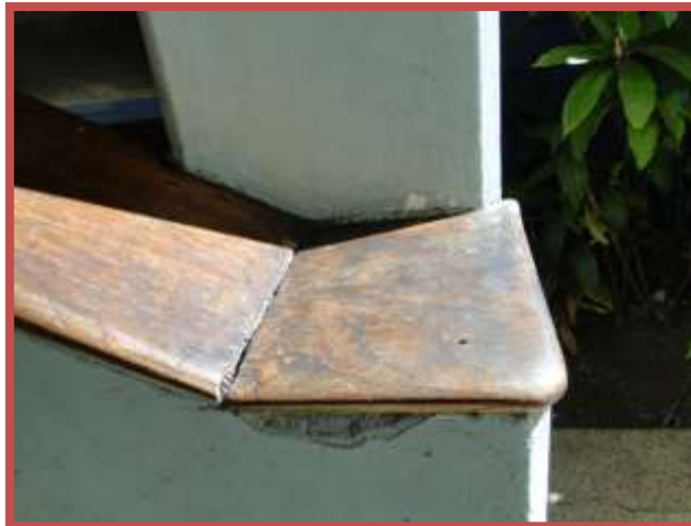
Figura No. 73. Alteración cromática en la madera de los pasamanos por falta de mantenimiento y pérdida del sellador y esmalte protector, 2011. Grupo Escolar “Agustín Zamora Quintana”. Tomado de <<Fotos propias del autor>>.
