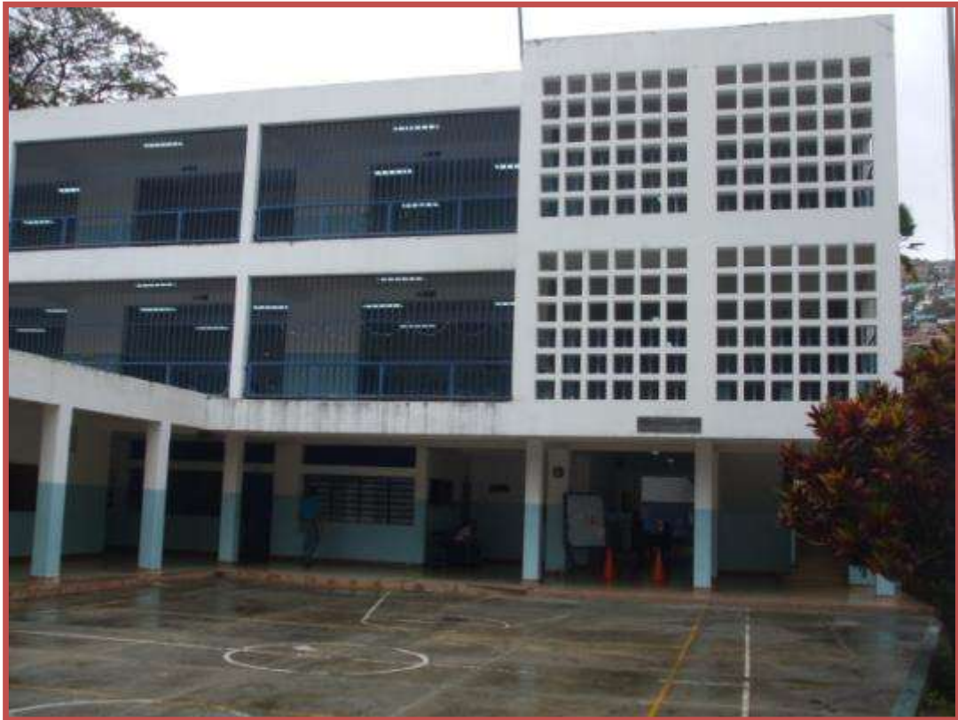
Figura No. 21. Fachada Sur, en la cual podemos observar la planta baja libre y sus columnas a la vista (2011). Tomado de <<Fotos propias del autor>>.
