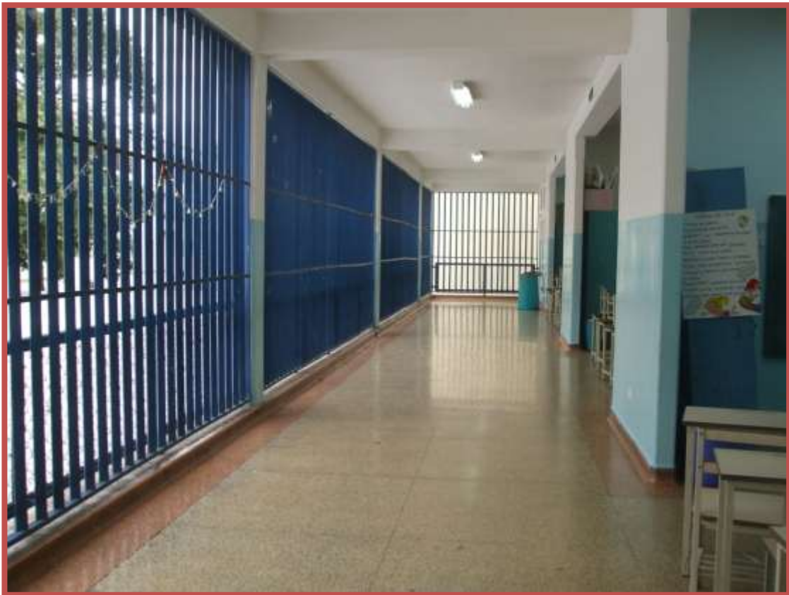
Figura No. 30. Vista de uno de los pasillos del ala sur de la edificación, 2011. Se observan las aulas abiertas. Tomado de <<Fotos propias del autor>>.
