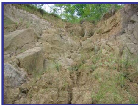
Fig. 63: Movimientos complejos (caída de bloque, flujo de detritos y deslizamiento translacional) .
