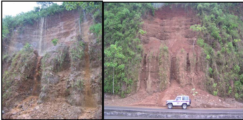
Fig. 23: Proceso en el talud T18-2- 27.
