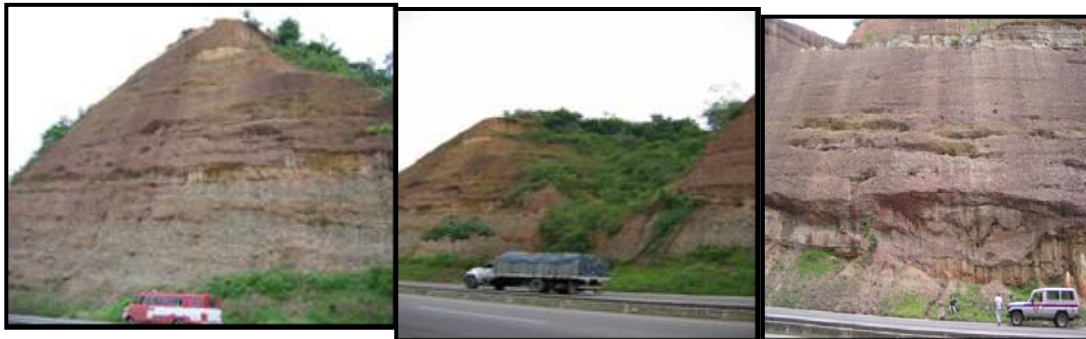
Fig. 38: Taludes T8-2-10, T7-2-9 y T6-2-8, respectivamente. Se observa la constancia lateral del material conglomerático y lutítico, presentándose en estos últimos, niveles de socavación considerables (sentido Trujillo Valera).
