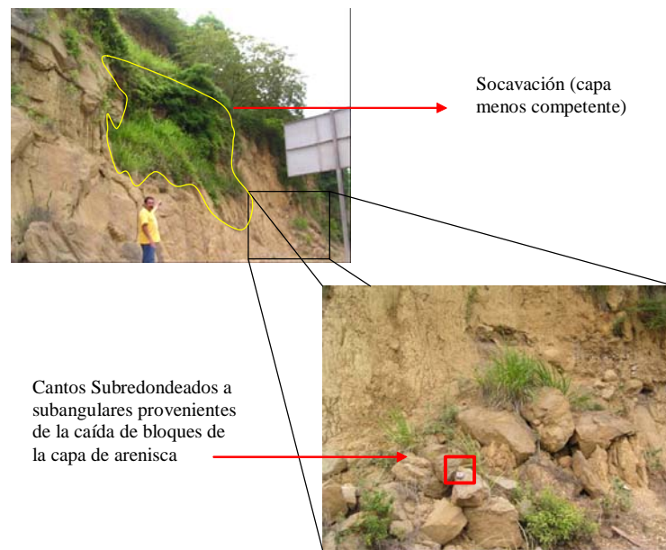
Fig. 31: Se evidencia el grado de socavación que presenta la capa de lutita, trayendo consigo la inestabilidad de la capa de areniscas, en forma de caída de bloques (talud ubicado en la entrada de Valera, Eje Vial, T24-1-24.
