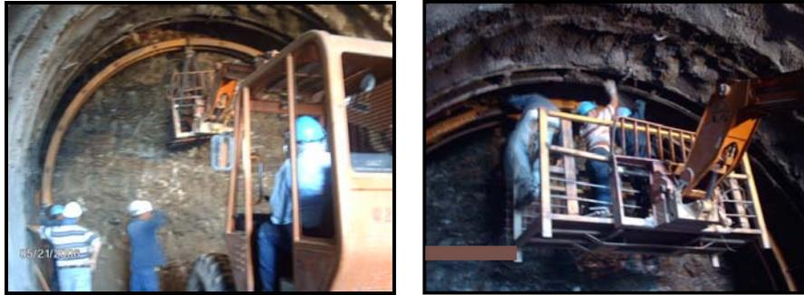
**Figura 7.2.** Colocación de Costillas. Túnel trasvase Taguaiguay-Valles de Tucutunemo.
