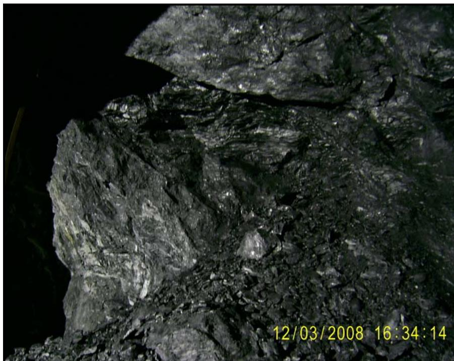
**Figura 9.24.** Frente de excavación Túnel Trásvase Taguaguay-Valles de Tucutunemo. Filita Grafitosa. Tomada por: Rosangela Martínez. (2008).
