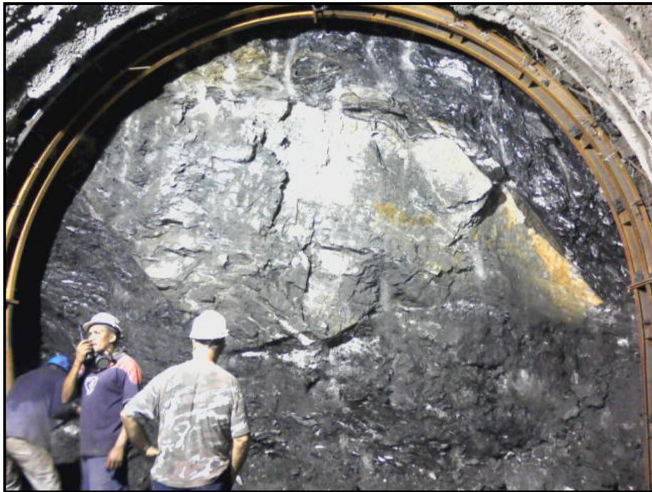
**Figura 9.29.** Disposición del bloque de diabasa en el frente de excavación. Progresiva 0+110.57. Tomada por: Rosangela Martínez (2008)
