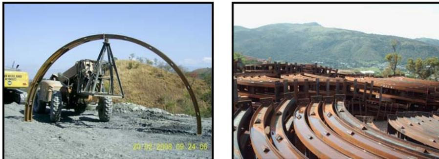
**Figura 7.3.** Costillas utilizadas en el Túnel trasvase Taguaiguay-Valles de Tucutunemo.
