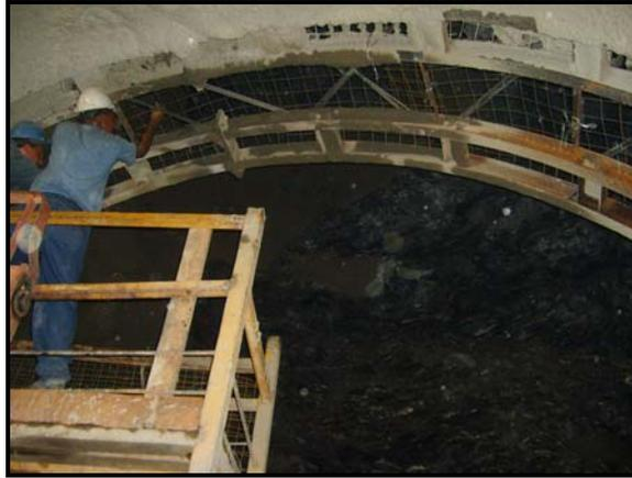
**Figura 7.4.** Malla electrosoldada 10X10 utilizada en el Túnel trasvase Taguiguay-Valles de Tucutunemo. Tomada por: Rosangela Martínez (2008)
