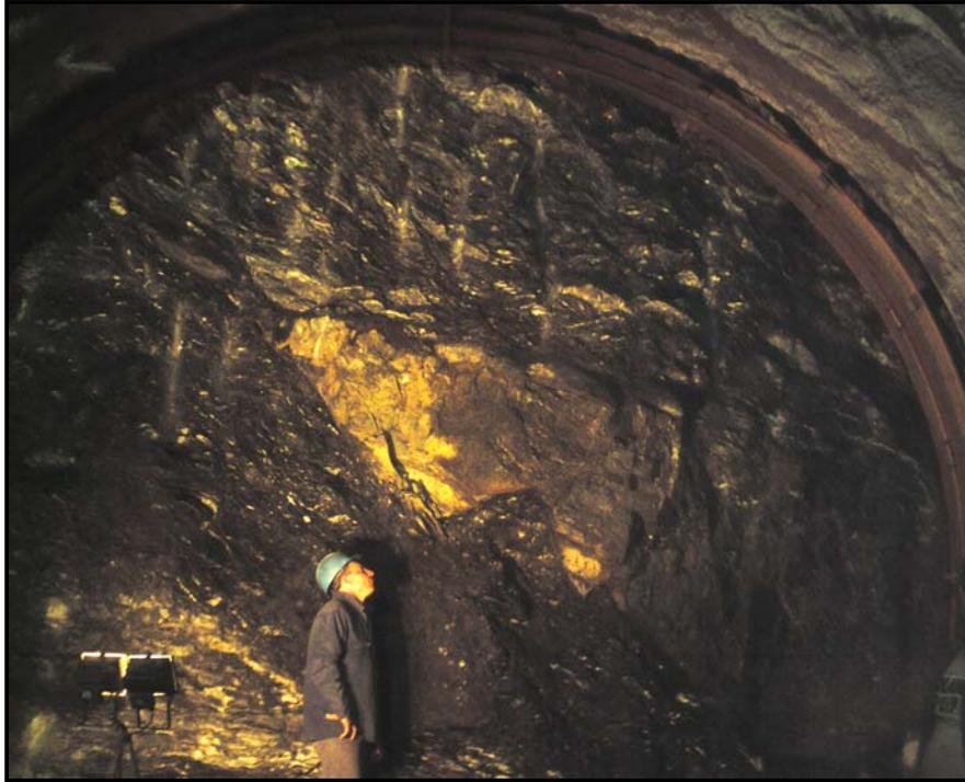
**Figura 9.27.** Disposición del bloque de meta-arenisca en el frente de excavación.
