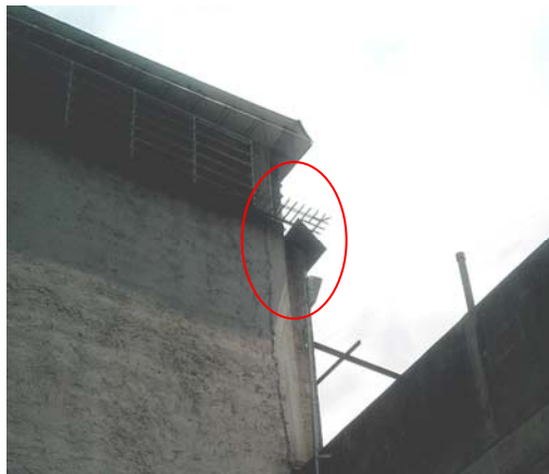
Antena Suscriptora instalada
