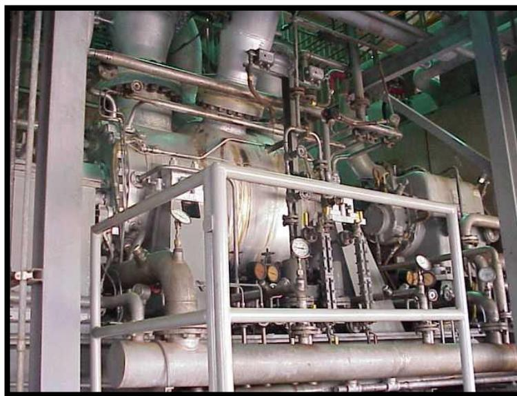
Figura 5. 20: Turbocompresor centrífugo <sup>[28]</sup>
