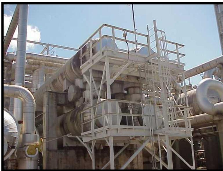
Figura 5. 17: Intercambiador gas frío / gas de baja presión <sup>[28]</sup>
