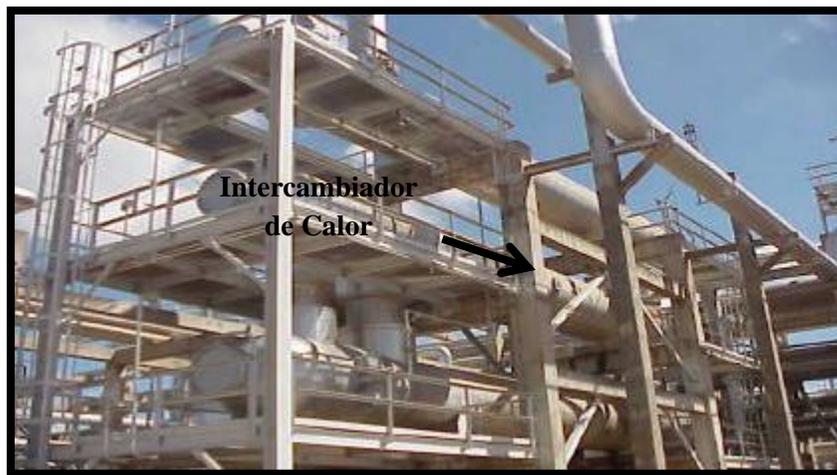
Figura 5. 14: Intercambiador de gas caliente/ gas de alta presión <sup>[28]</sup>
