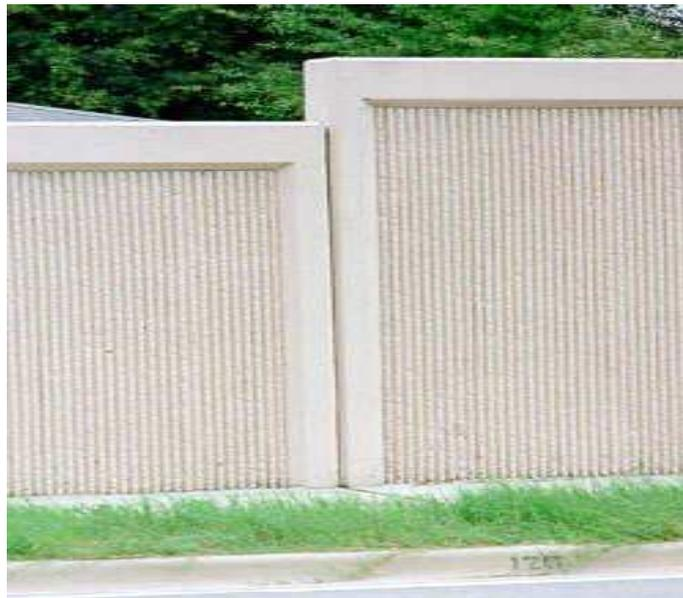
Fig. 4.7 Barrera anti-ruido de Concreto
