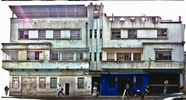
Imagen Nº 54 Otras edificaciones en Marín, 2009.
