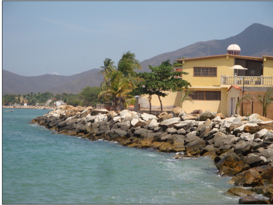
Fotografía N° 7. Escolleras en el sector El Palotal.
