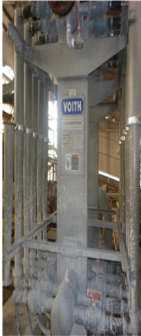
**Figura N°31 B. Sistema de batería de Limpiadores cónicos reversos. Vista frontal.**
