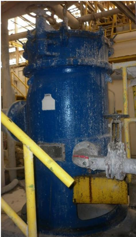
**Figura N°28 A. funcionamiento de depurador presurizado.**
