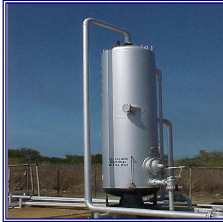
Figura 19. Separador vertical
