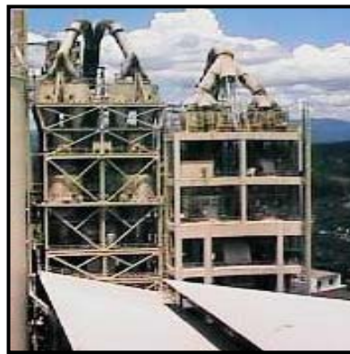
Figura N° 4 Vista de las torres de ciclones de Horno 1 (izquierda), y Horno 2.
