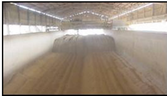
Figura N° 1: Vista frontal del patio de Pre – Homogeneización de arcilla.
